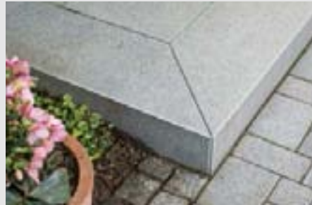
Gehrungsschnitte bei Blockstufen – ob Naturstein oder Keramik-Verbund-Produkte ...
