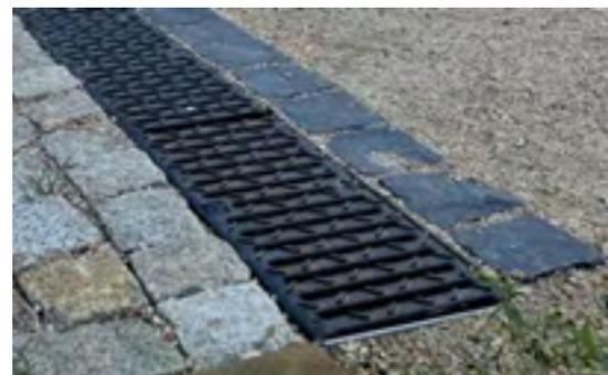
**MEA Guss-Stegroste (Belastungsklasse D 400) sorgen für sicheren Halt durch CLIPFIX-System mit Längsverschiebesicherung**
