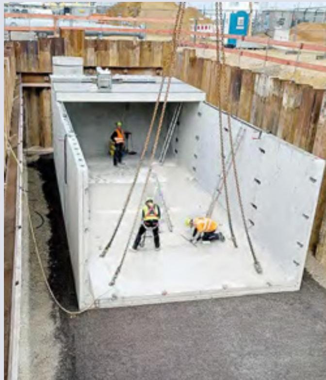
Die modularen, gereihten Anlagen von FUCHS eignen sich mit Volumina von 50 bis 1.000 m<sup>3</sup> optimal für die Rückhaltung und Speicherung großer Mengen Regen- oder Löschwasser
