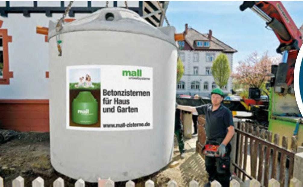
Ein Regenspeicher aus Beton wird direkt vom Lieferfahrzeug in die Baugrube gehoben (Mall GmbH)
