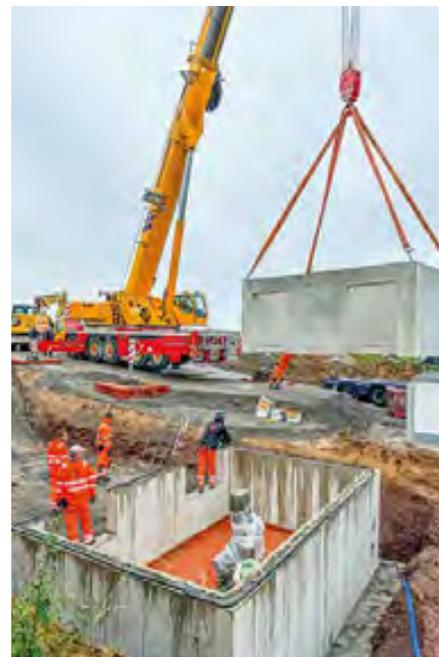
Im ersten Schritt wurden die Fertigteile versetzt, in denen die Pumpentechnik für die Druckerhöhungsanlage ihre Arbeit verrichtet
