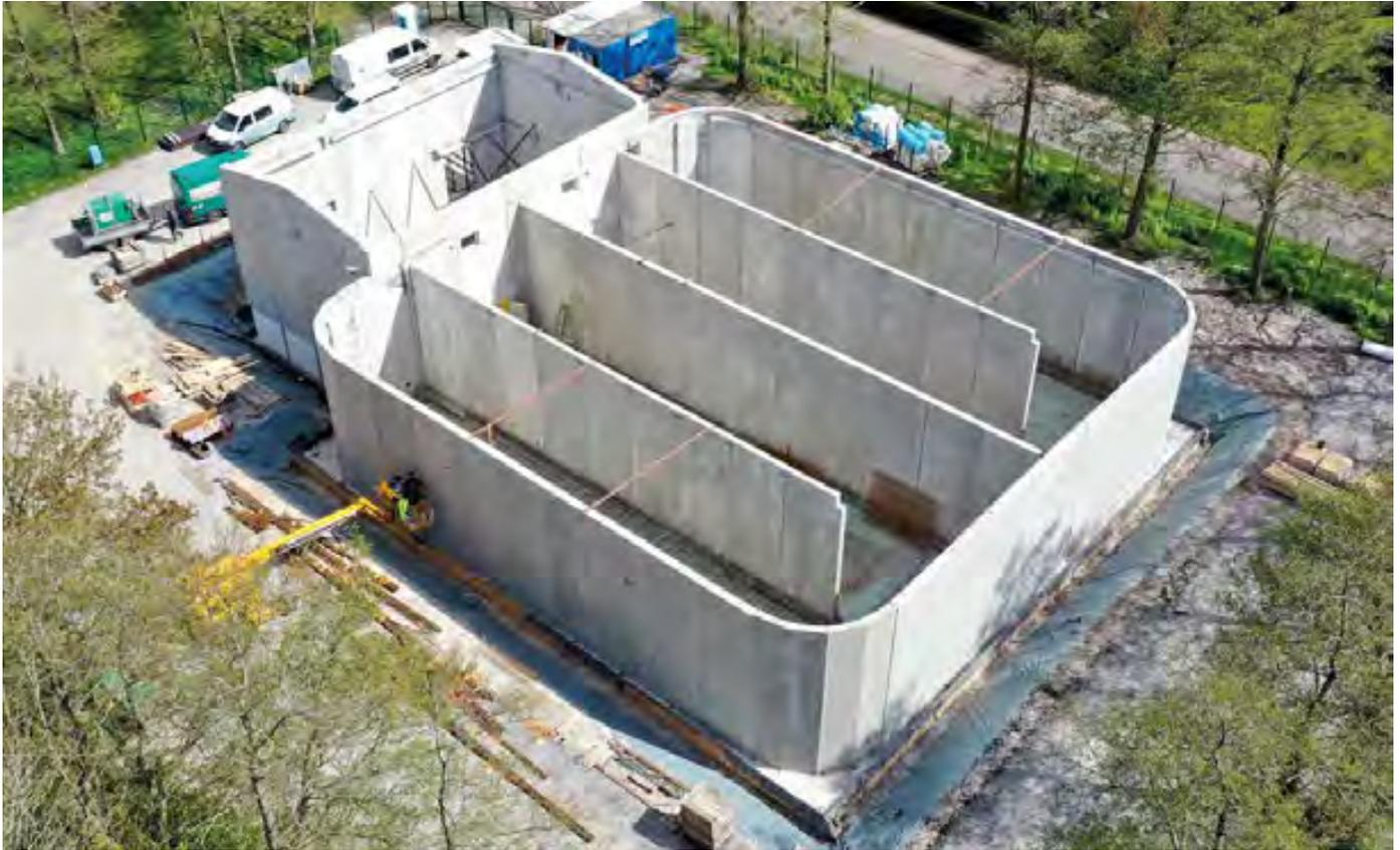
FUCHS Spannbetonbehälter – System DRÖSSLER: Lösungen für Wasser, Abwasser und für die Landwirtschaft in diversen Geometrien mit Größen bis über 25.000 m<sup>3</sup>
