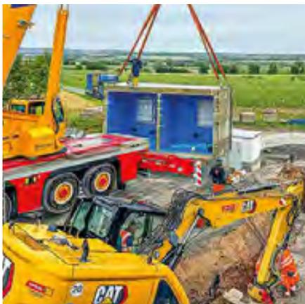
**Die Trinkwasserspeicher bestehen aus zwei Kammern und sind mit PEHD ausgekleidet**
