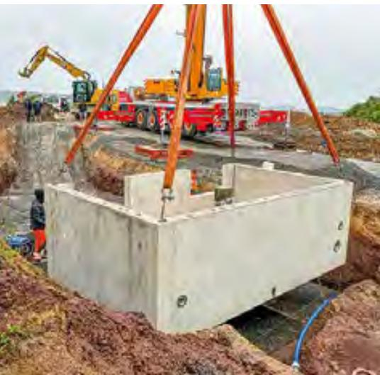
Das erste von 6 Bauwerken wird in die Baugrube versetzt
