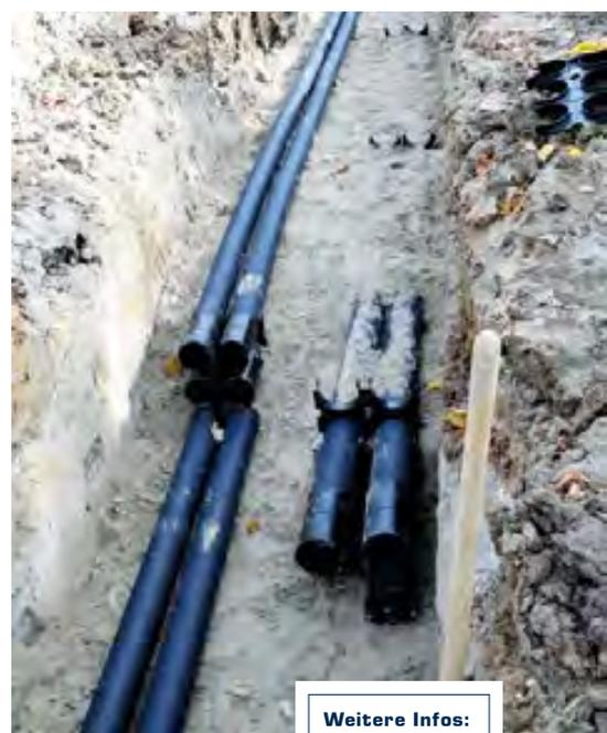
Erdverlegte Schutzrohre in mehrlagiger Paketanordnung
