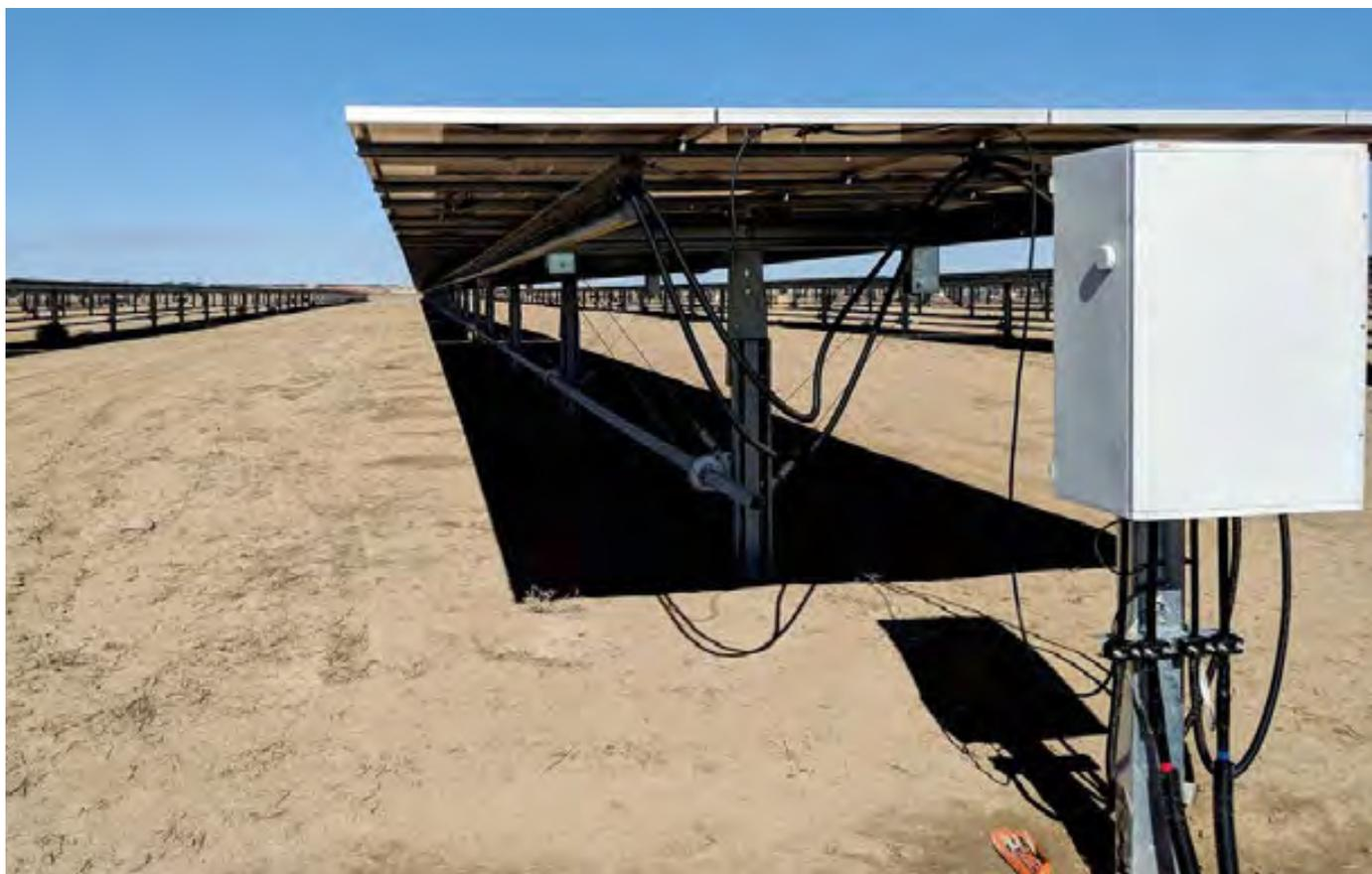
Oberirdisch verlegte Kabelschutzrohre für einen wirksamen Schutz gegen UV-Einwirkung und mechanische Belastung
