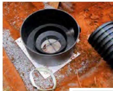
Das Unterteil des Wirbel-Feinfilters in der Baugrube eingebaut
