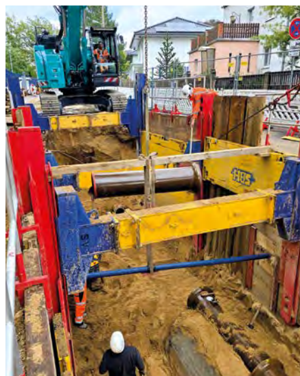
Herablassen eines weiteren Rohres
