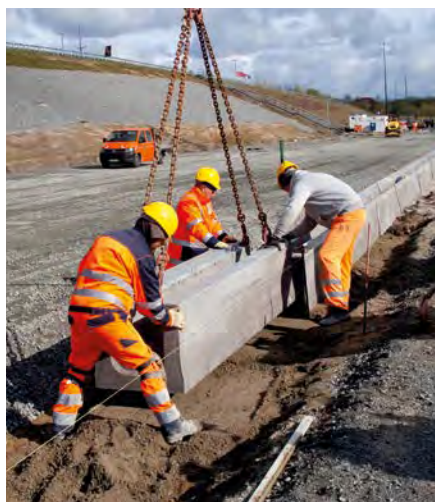
Die Verlegung der 3-Meter-Bauteile BIRCOmassiv erfolgt schnell und einfach von oben
