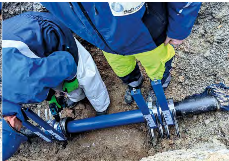
Einfache Montage der FRIASAFE von oben, ohne seitliche Schrauben
