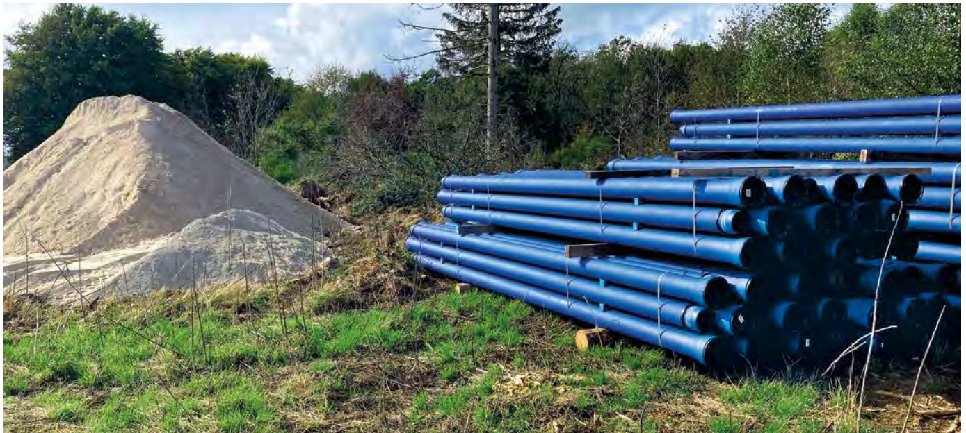
Einbau von NATURAL-Rohren im Moseltal
