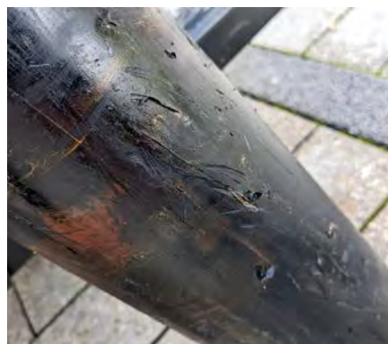
Das beschädigte PE-Rohr wurde entfernt
