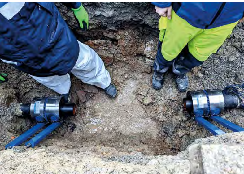
FRIASAFE wird mithilfe der Tangentialspanner über das Rohr geschoben
