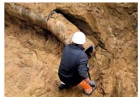
Abbruch des alten Kanals aus Beton
